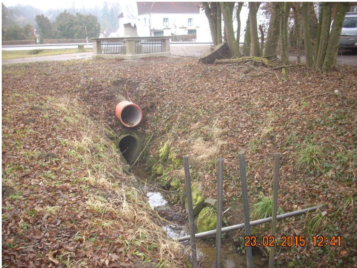
Schlossbach-Schwertberg Absetzbecken, Notentlastung (vorher-nachher)
