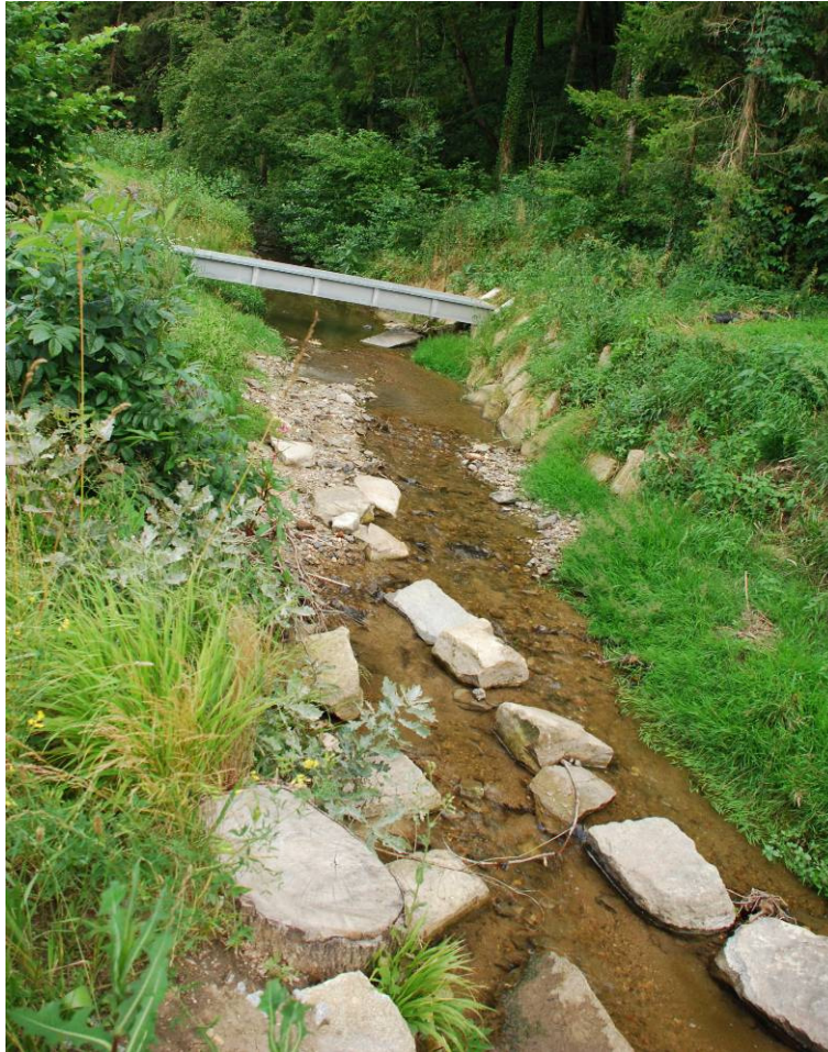
Abbildung 7: Kamigquerung neu (Blick nach Nordosten), Bild vom 26.06.2014
