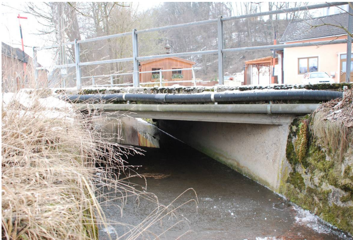
Abbildung 2: Reindlbrücke (Blick nach Osten), Bild vom 31.01.2011
