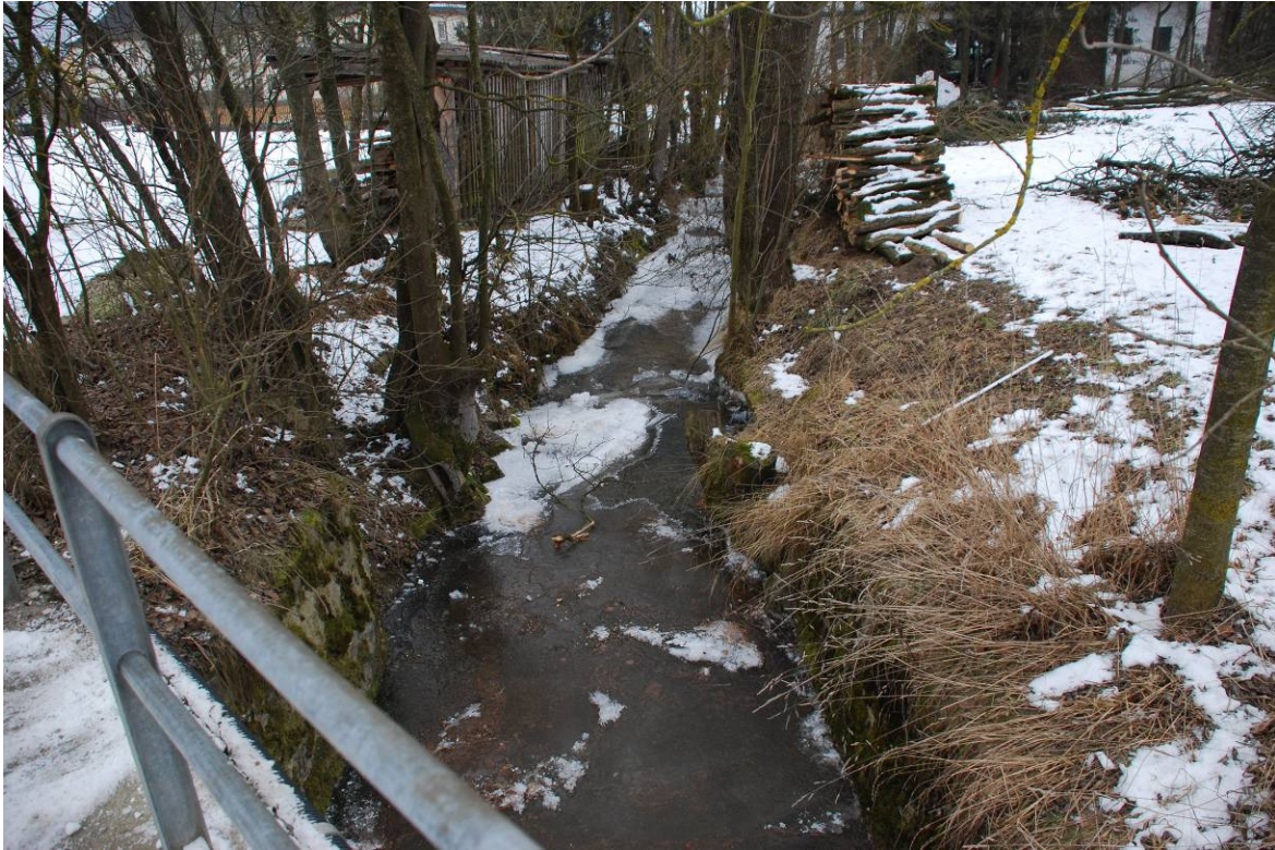
Abbildung 3: Aisthofener Bach unterhalb der Reindlbrücke (Blick nach Südosten), Bild vom 31.01.2011
