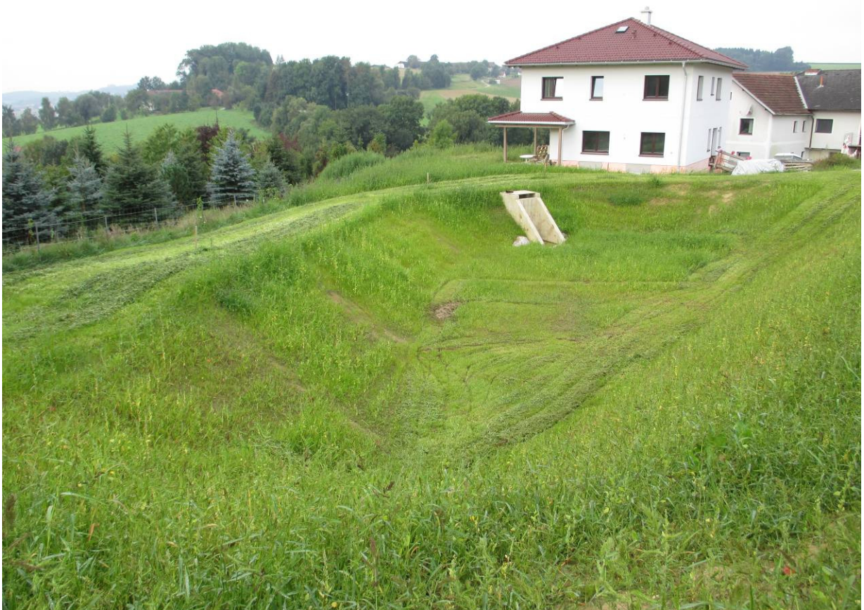
Abbildung 2: Retentionsbecken (Blick nach Westen), Bild vom 09.09.2014
