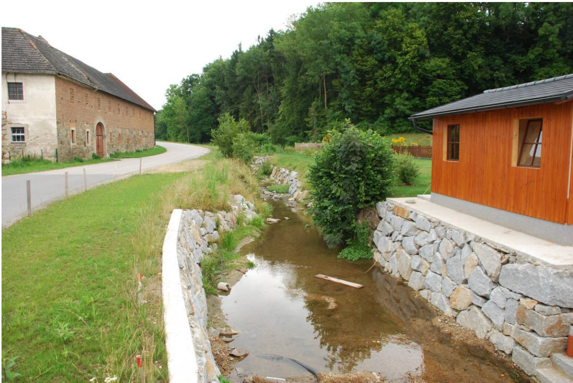
Abbildung 4: Aisthofener Bach oberhalb der Reindlbrücke (Blick nach Nordosten), Bild vom 11.07.2014
