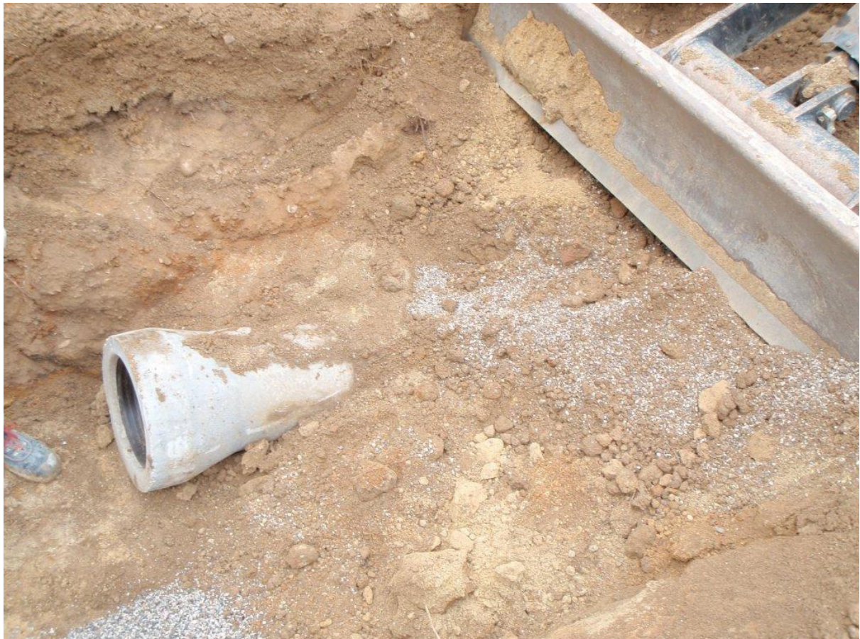
Abbildung 4: Verlegung der Hangwasserableitung, Bild vom 11.09.2013
