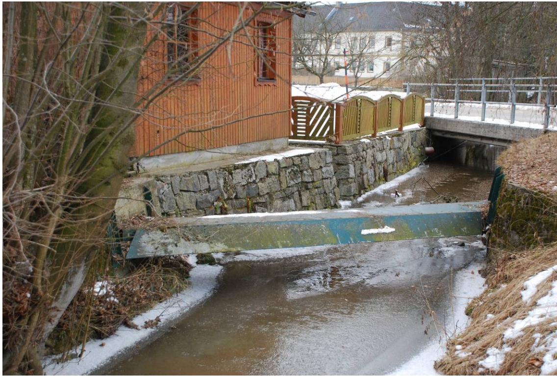
Abbildung 1: Aisthofen mit Kamigquerung oberhalb der Reindlbrücke (Blick nach Südosten), Bild vom 31.01.2011
