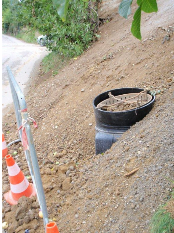
Abbildung 5: Versetzen des Energieumwandlungsschachtes, Bild vom 11.09.2013
