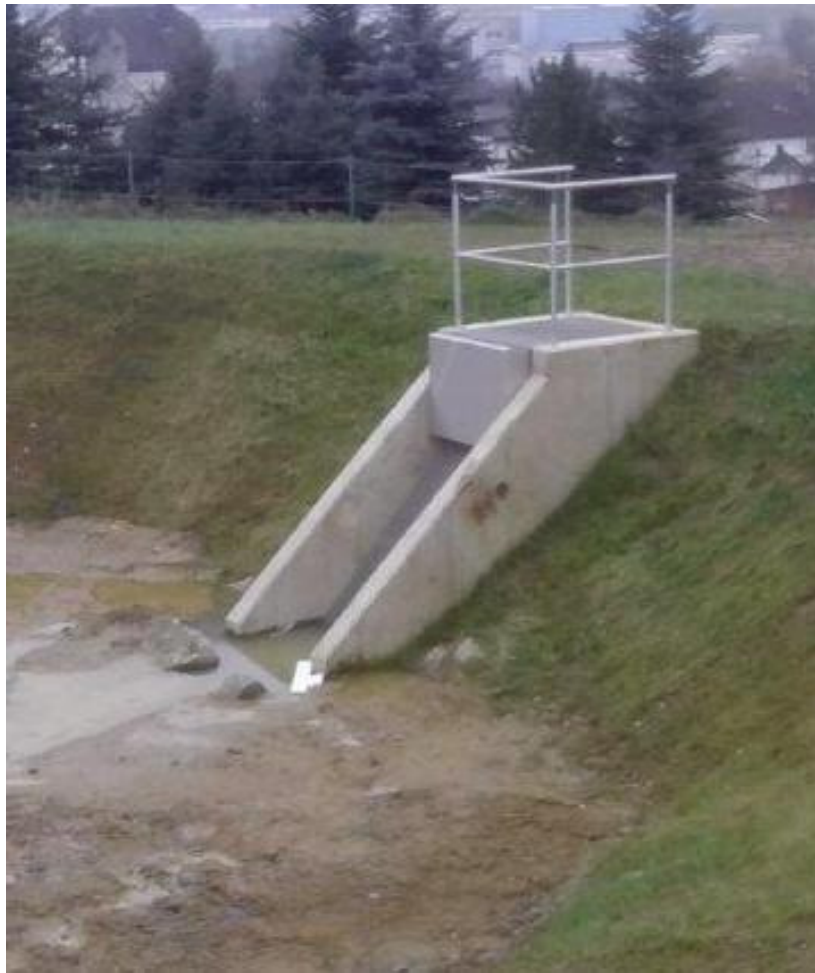
Abbildung 3: Auslaufbauwerk, Bild vom 21.01.2015
