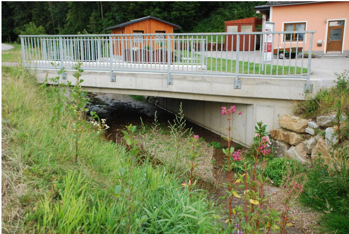
Abbildung 5: Reindlbrücke (Blick nach Osten), Bild vom 11.07.2014
