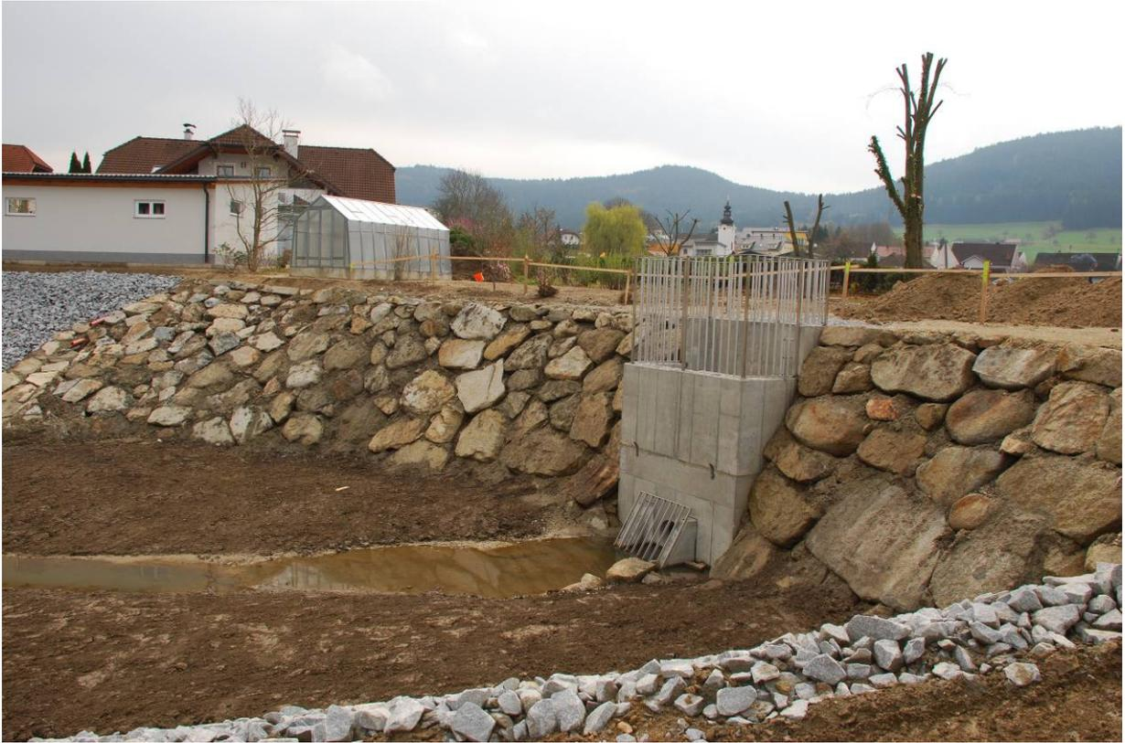
**Abbildung 5: Becken Nord Ablaufdrosselbauwerk und Natursteinmauer (Blick nach Süden), Bild vom 23.04.2015**
