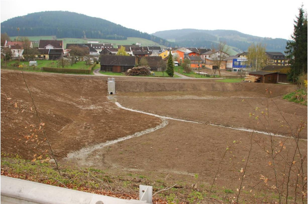
**Abbildung 9: Becken Süd mit Ablaufdrosselbauwerk und Überdeckung Schmutzwasserkanal rechts im Bild (Blick nach Süden), Bild vom 23.04.2015**
