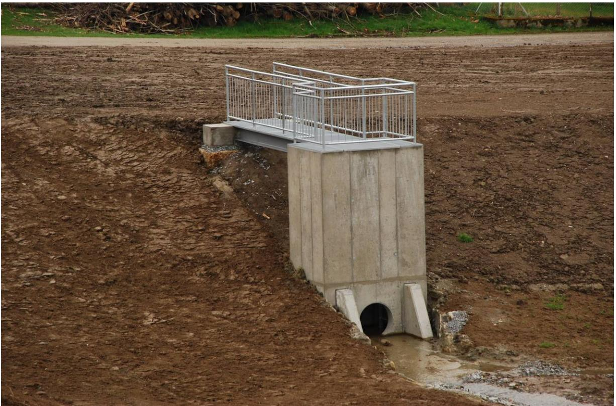
**Abbildung 10: Becken Süd Ablaufdrosselbauwerk, Bild vom 23.04.2015**
