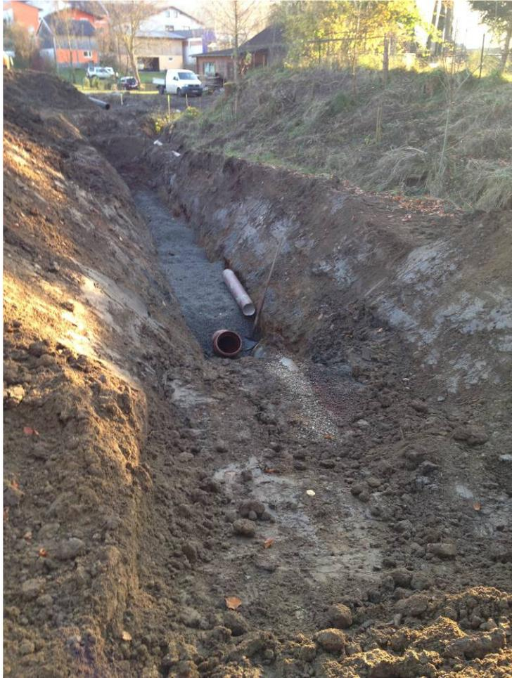
**Abbildung 11: Becken Süd Verlegung Schmutzwasserkanal, Bild vom 17.11.2014**
